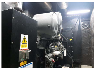
ภาพที่ 1.3-13 เครื่องกำเนิดไฟฟ้าสำรองขนาด 650 KVA
