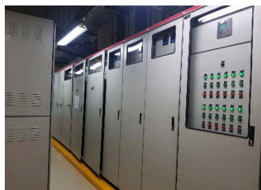
ภาพที่ 1.3-12 แผงจ่ายไฟฟ้าหลัก
