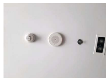
เครื่องตรวจจับควันและกริ่งเตือนภัย
